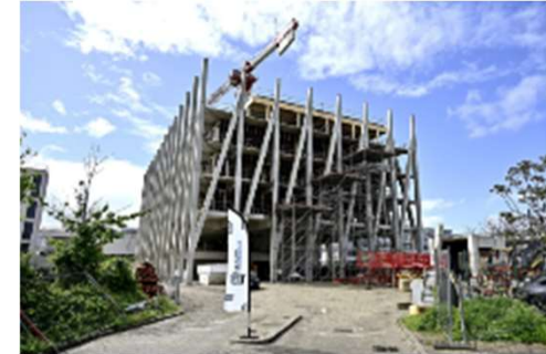
I-FACTORY : Futur lieu totem dans un bâtiment dédié à l'innovation 1200 m2 pour Inria de Lyon
